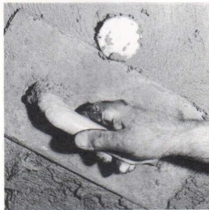
Bild 14: Das Beputzen ist für den Verputzer leicht, weil die »hervorragende« UP-Dose als Anschlag
